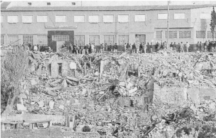
Ajuntamento de habitantes e de consumidores de droga em frente do Centro Social do Casal Ventoso após a demolição de grande parte do bairro abaixo da Rua Costa Pimenta.
